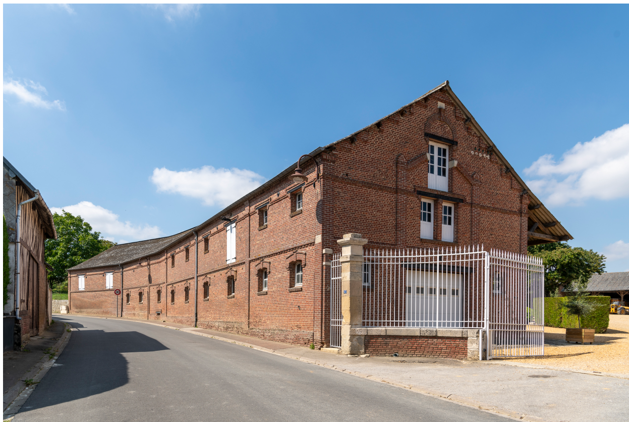
Bâtiments agricoles, architecte D. Martin (inscription), n°67 de la rue Roland-Mariage, vue prise depuis l'est.
