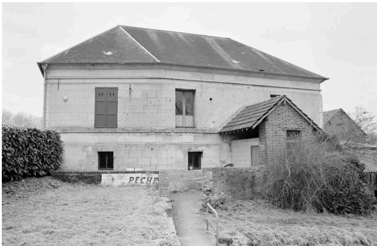
Atelier de fabrication doté de la cage de l'ancien moulin : façade postérieure.
