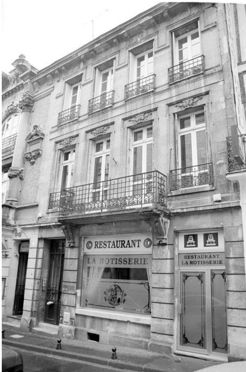
Façade sur rue : vue partielle.
