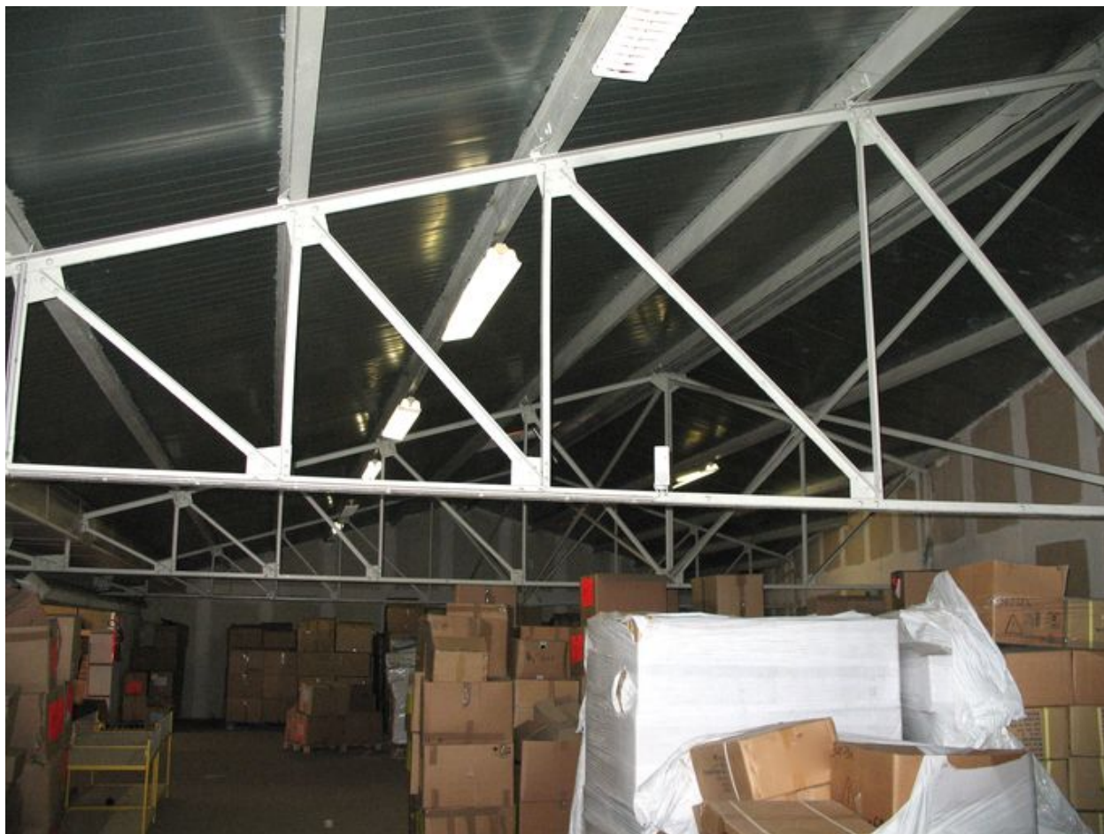
Charpente de l'un des entrepôts.
