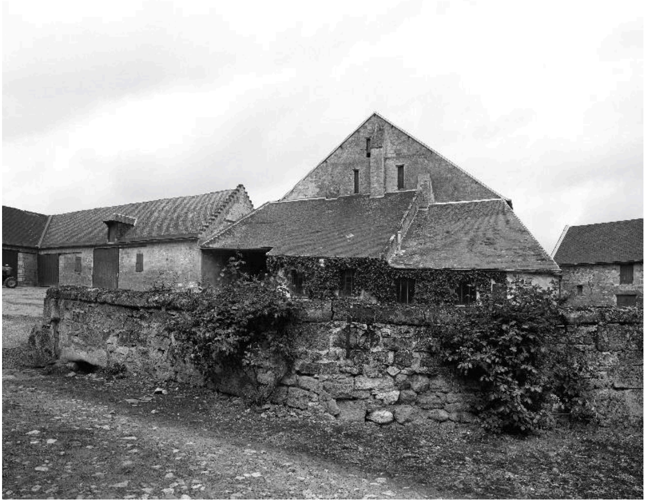
Vue du pignon sud-est de la grange et des étables attenantes.
