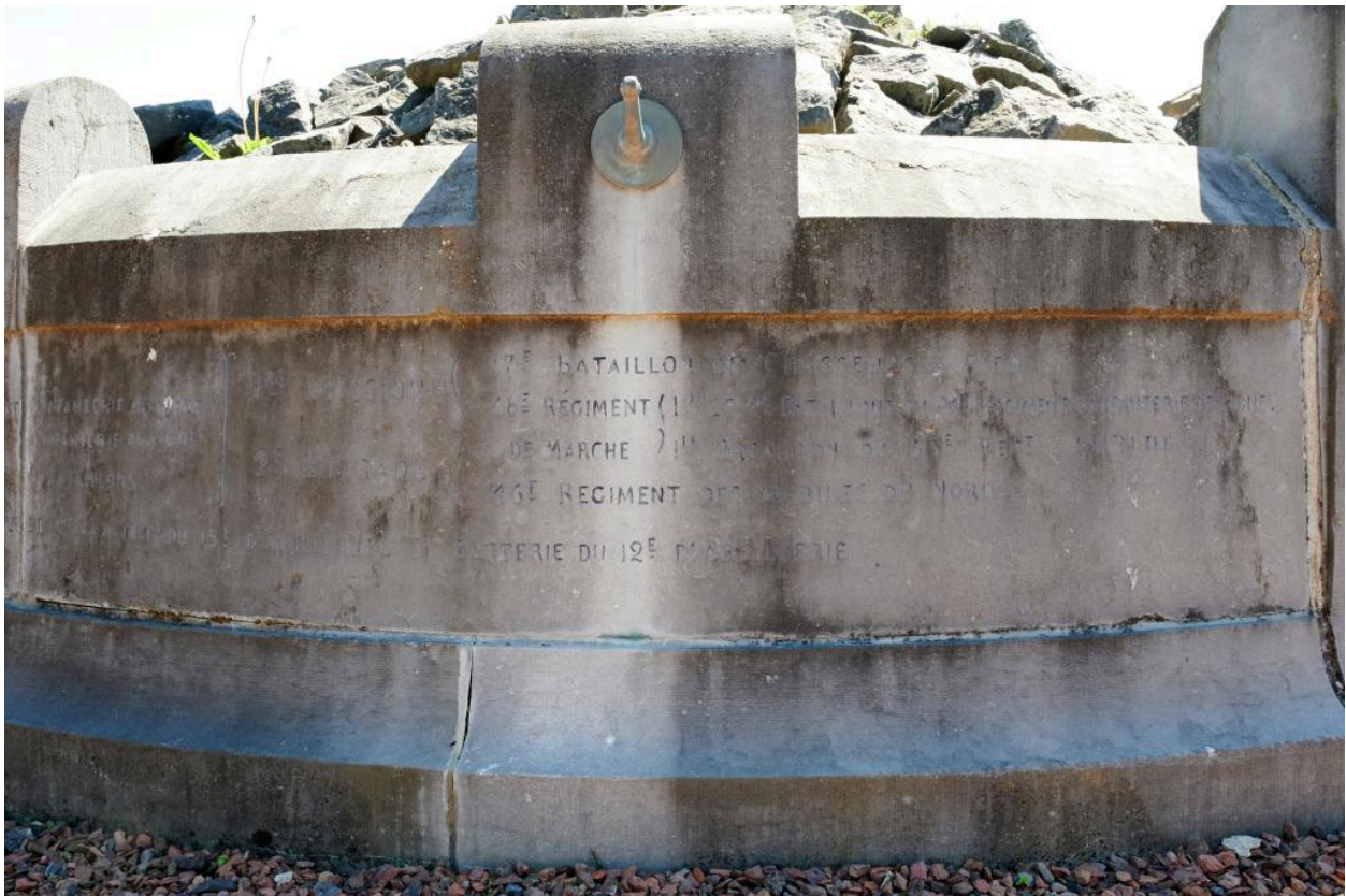
Vue de détail du panneau latéral 3 (numérotation depuis le panneau central avant dans le sens des aiguilles d'une montre).
