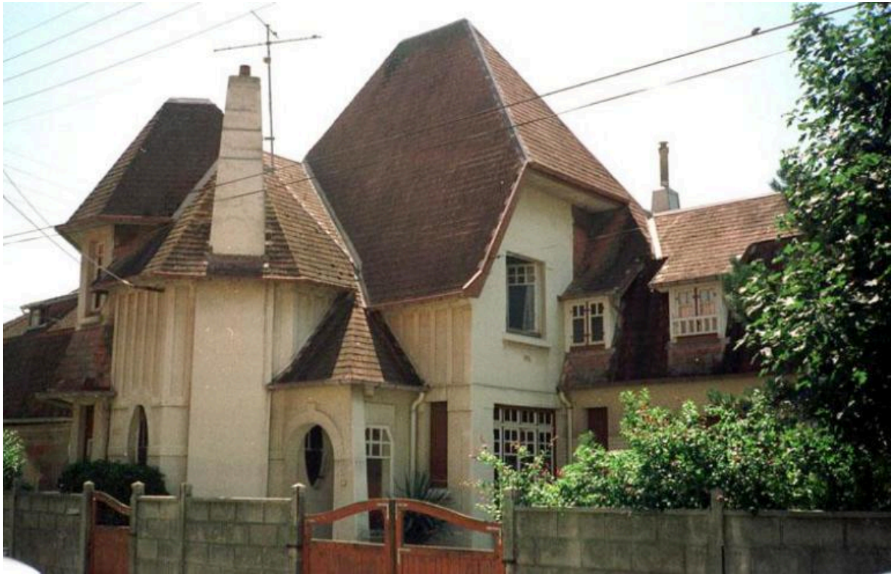
Vue d'ensemble de l'angle de la villa.
