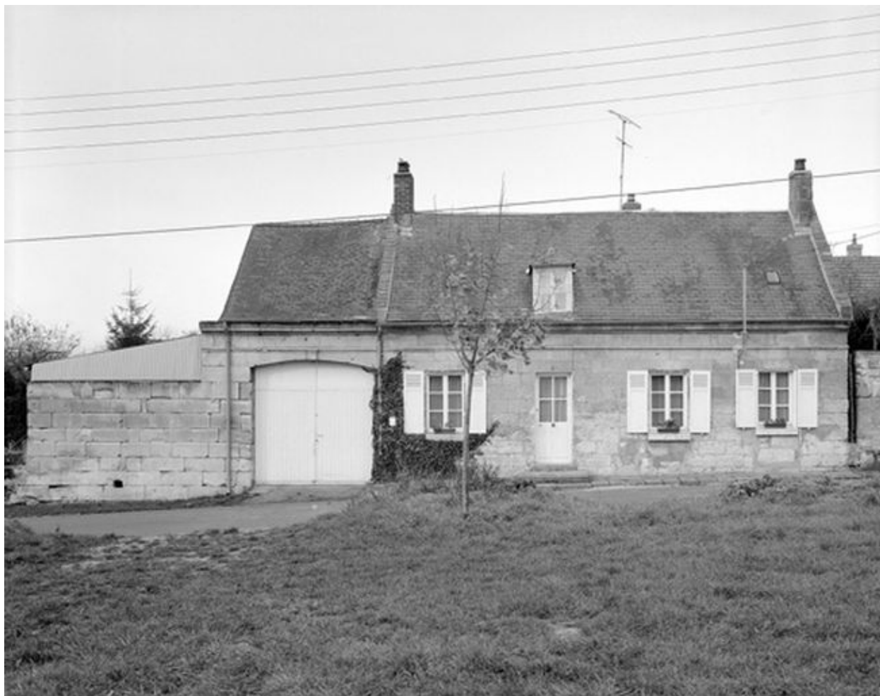
Logis. Vue générale.
