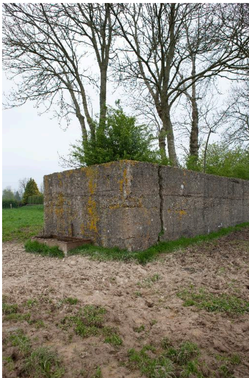
Second abri de stockage en forme de ski. Extrémité nord.
