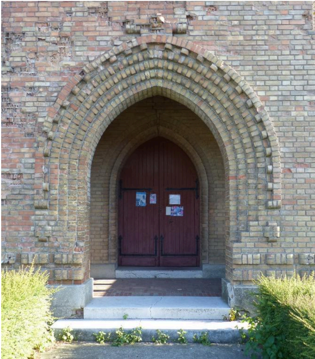
Vue de détail sur le porche et le portail de l'église.
