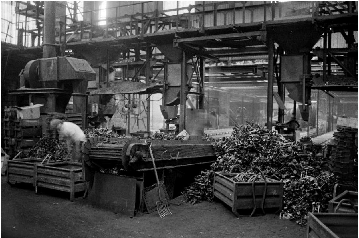
Atelier de fabrication, vue intérieure, en 1990.
