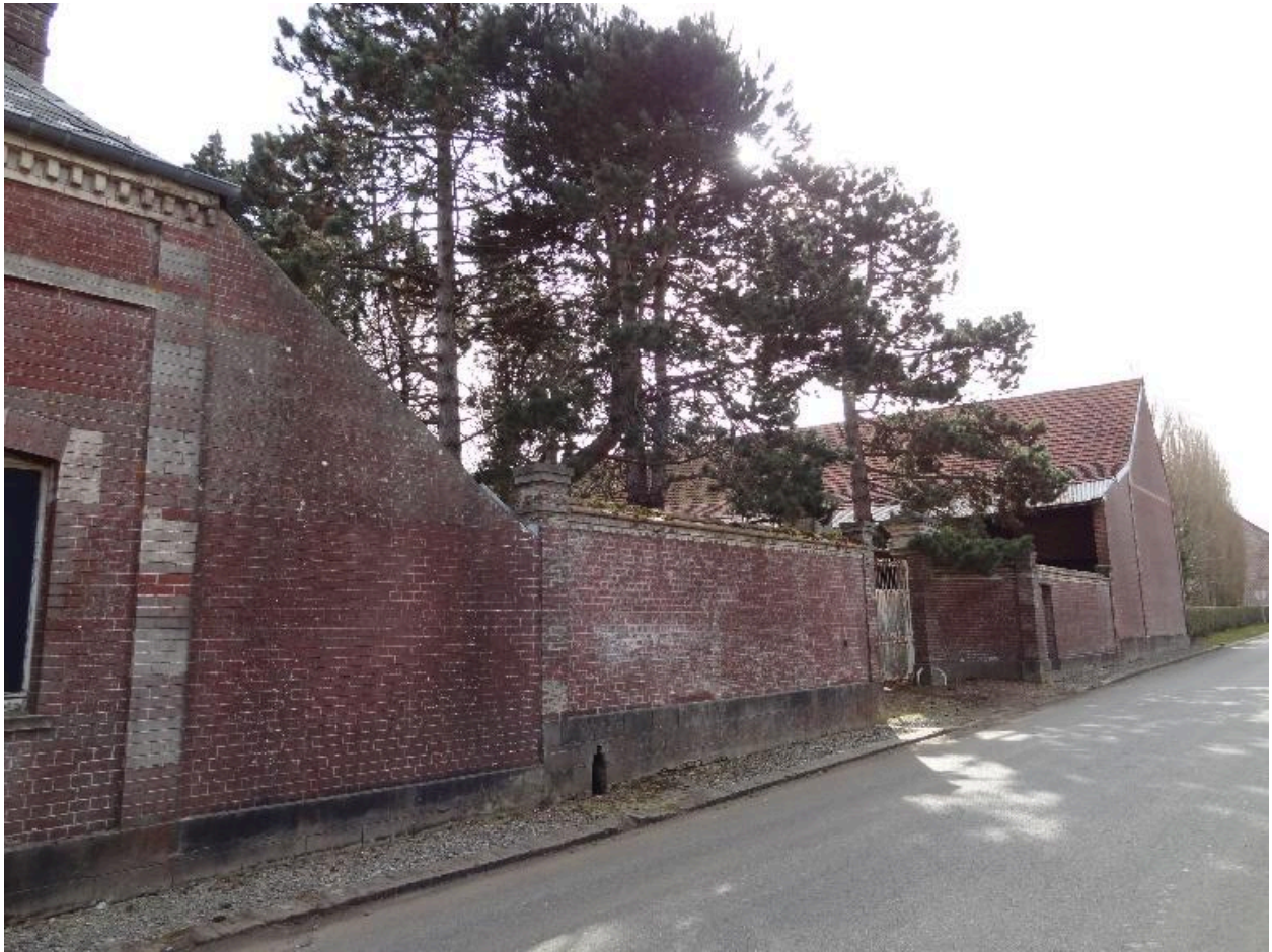
L'entrée de la ferme, depuis la rue de Martaigneville.
