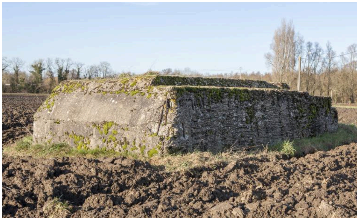
Vue de trois-quarts vers le nord.
