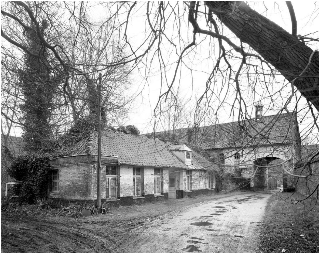
Ferme des Berceaux : entrée depuis l'avenue Clémenceau en 1999 : la conciergerie et le porche.
