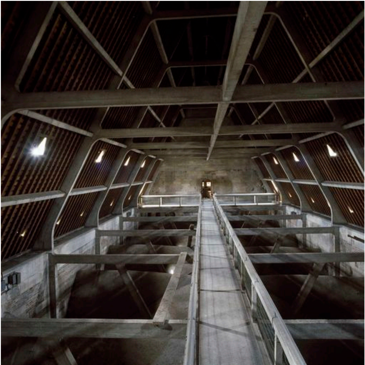
Charpente en béton de la nef, vue d'est en ouest.
