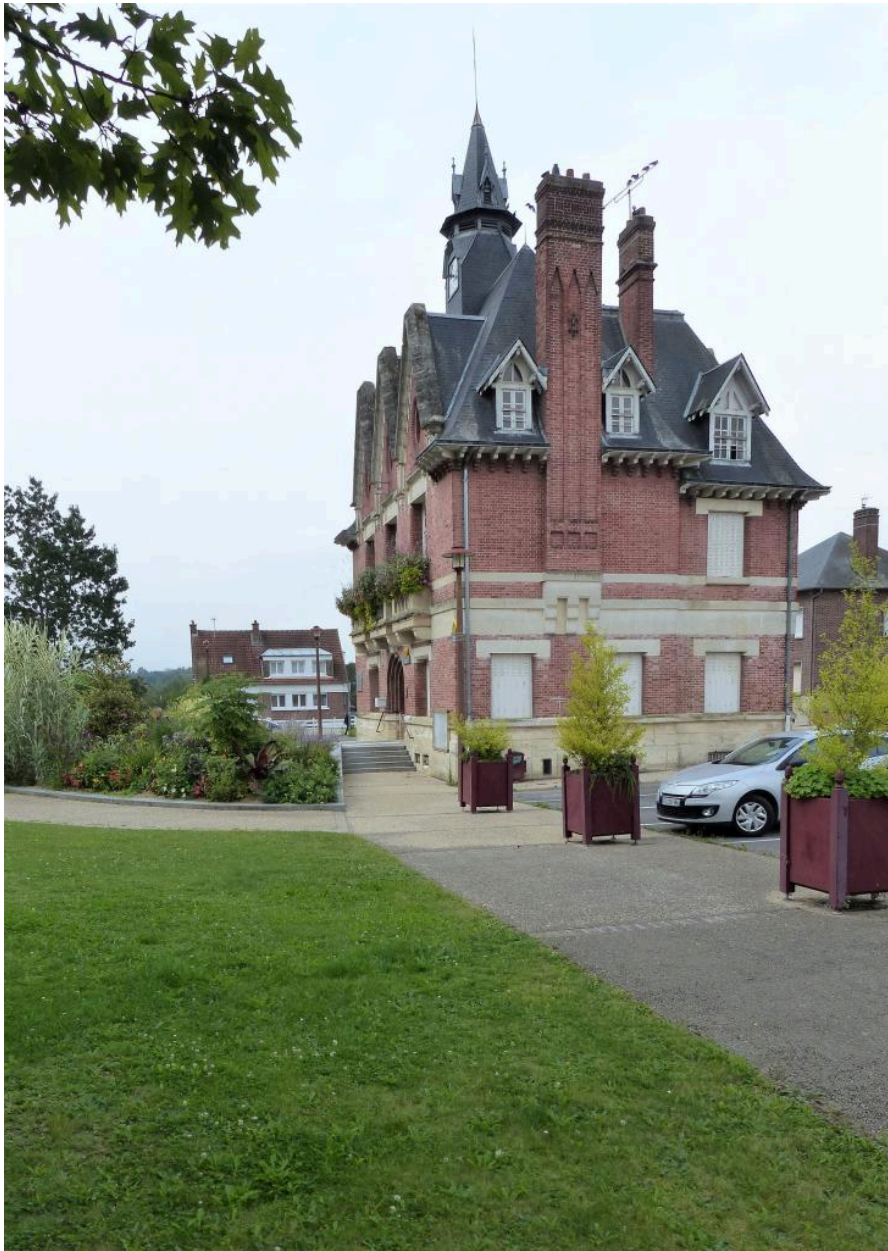
Vue générale depuis l'est.
