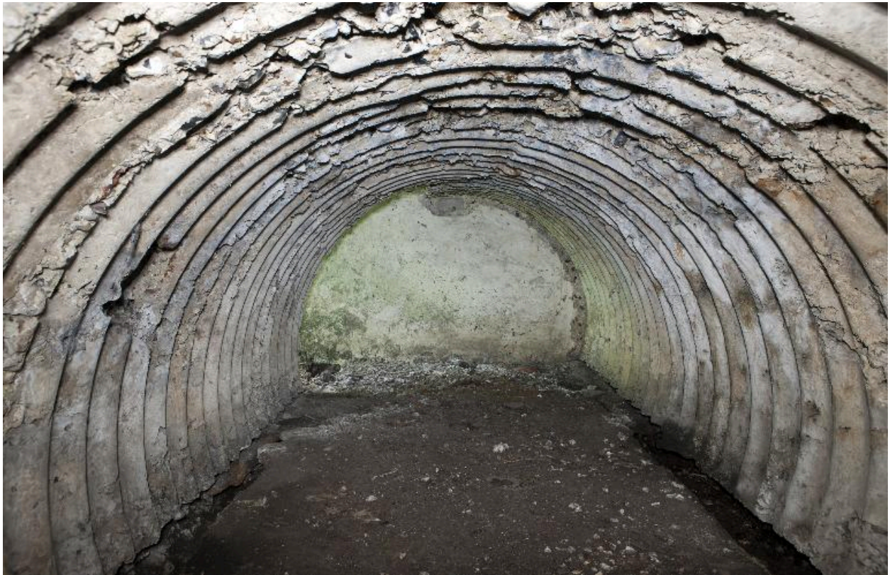
Casemate b) : Intérieur de l'abris
