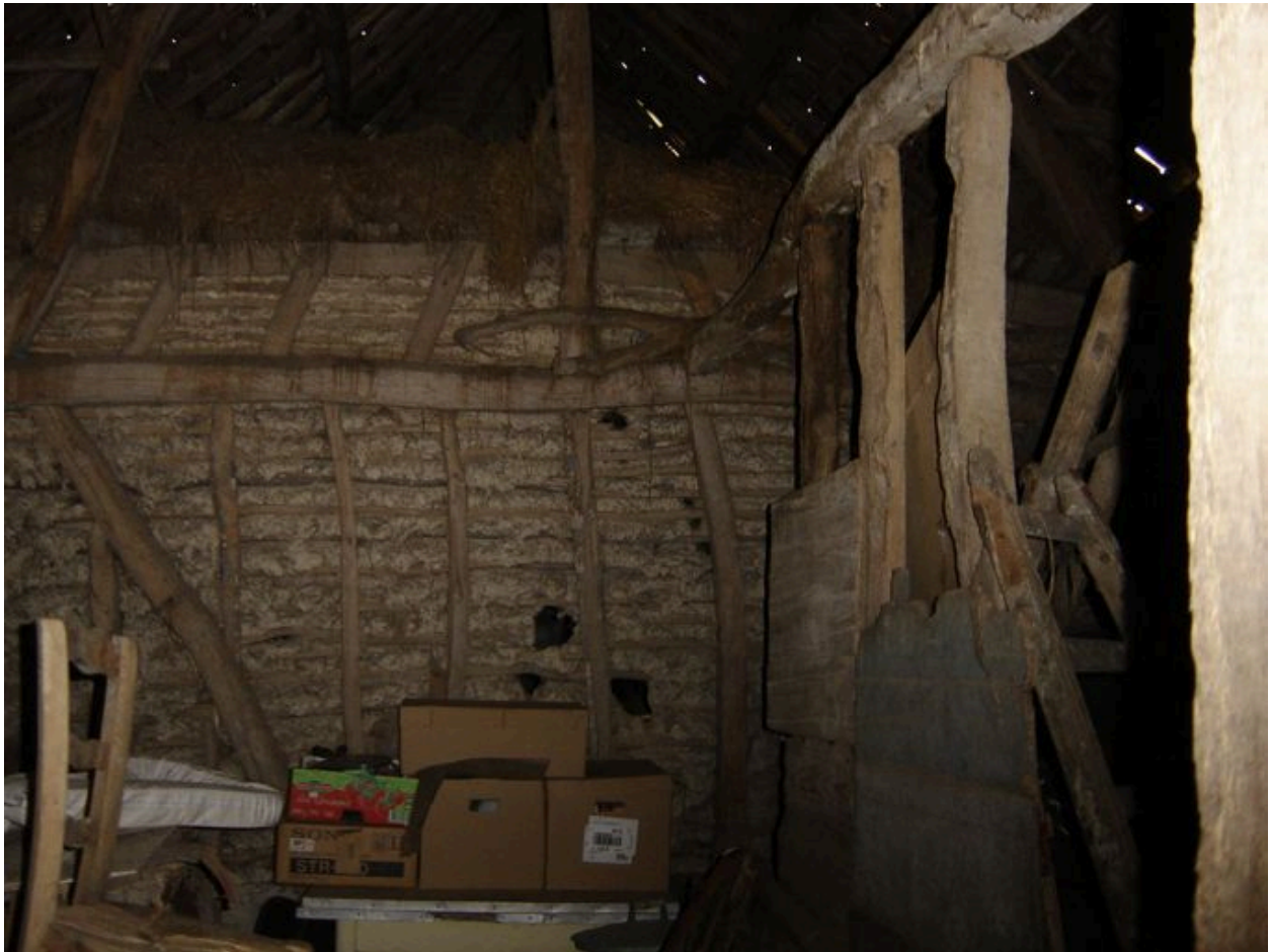
Vue intérieure de la grange.
