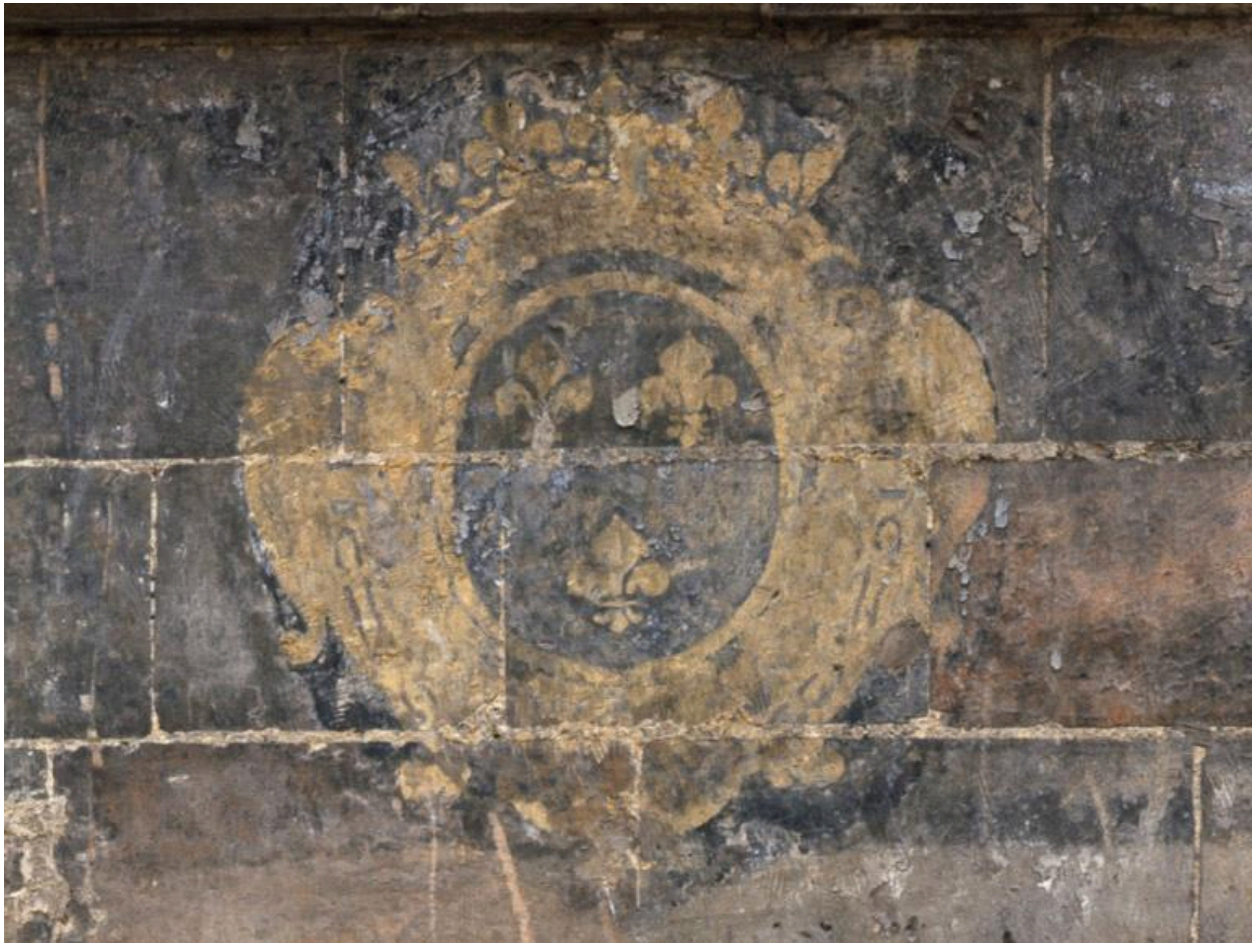
Vue de la litre peinte sur enduit de chaux à l'extrémité ouest du mur extérieur nord.
