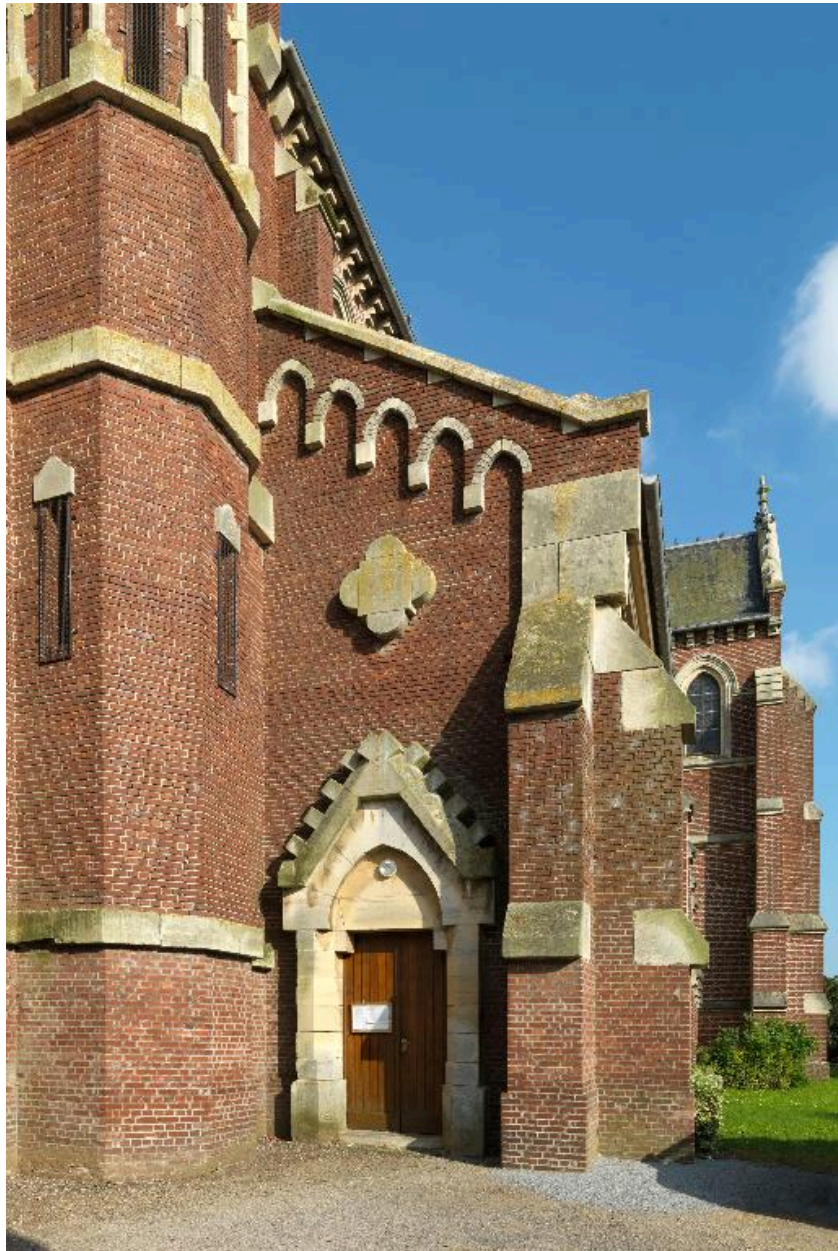
Vue de l'entrée secondaire par le bas-côté sud.
