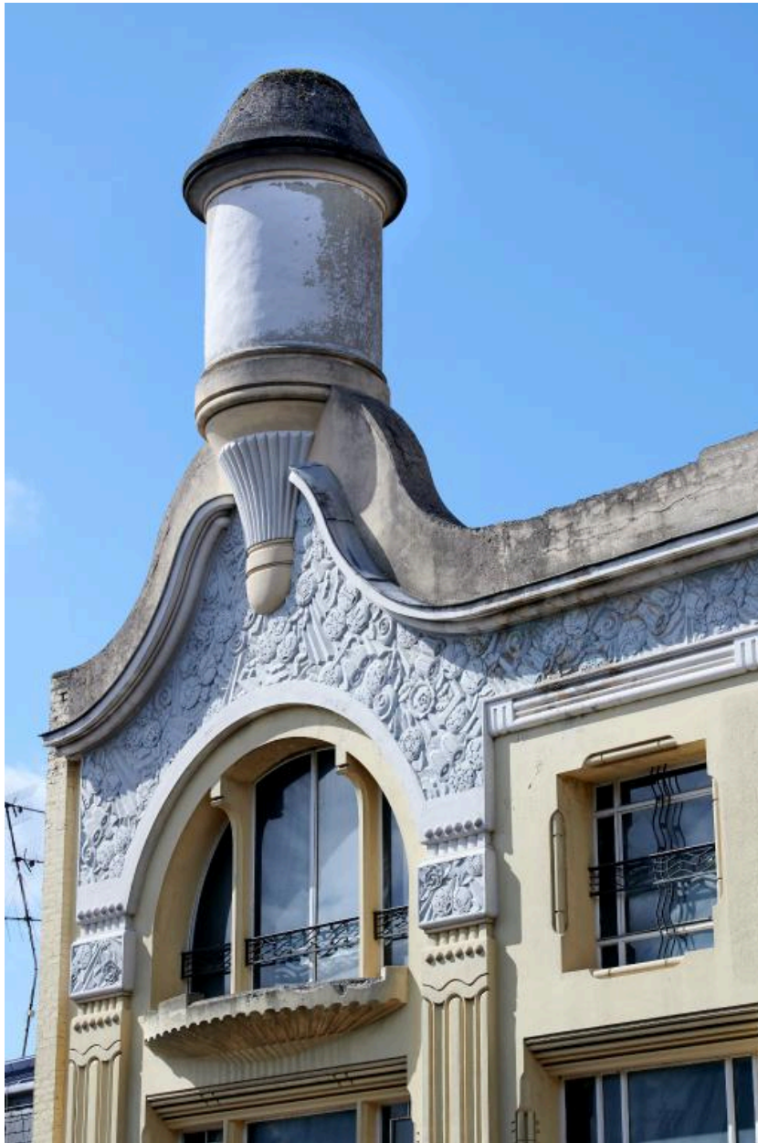
Détail de l'un des deux lanternons de la façade principale.
