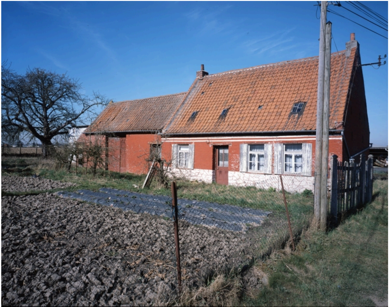
Vue de trois quarts depuis la rue de Guivarnes.
