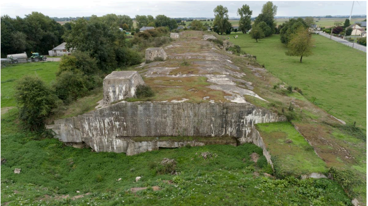
Vue aérienne longitudinale oblique vers le sud-ouest.
