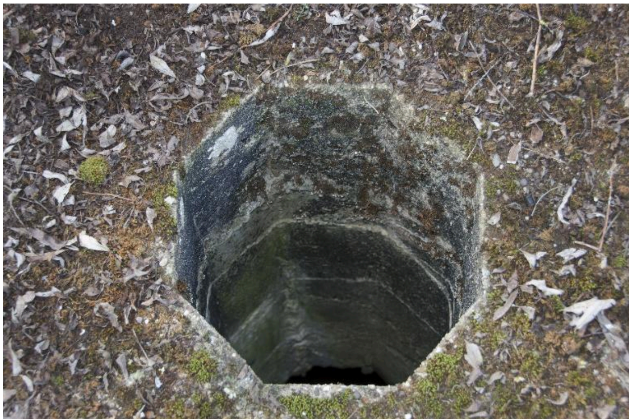
Couvrement. Sortie de la cheminée du périscopes
