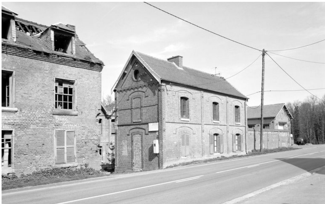
Conciergerie, élévation antérieure.
