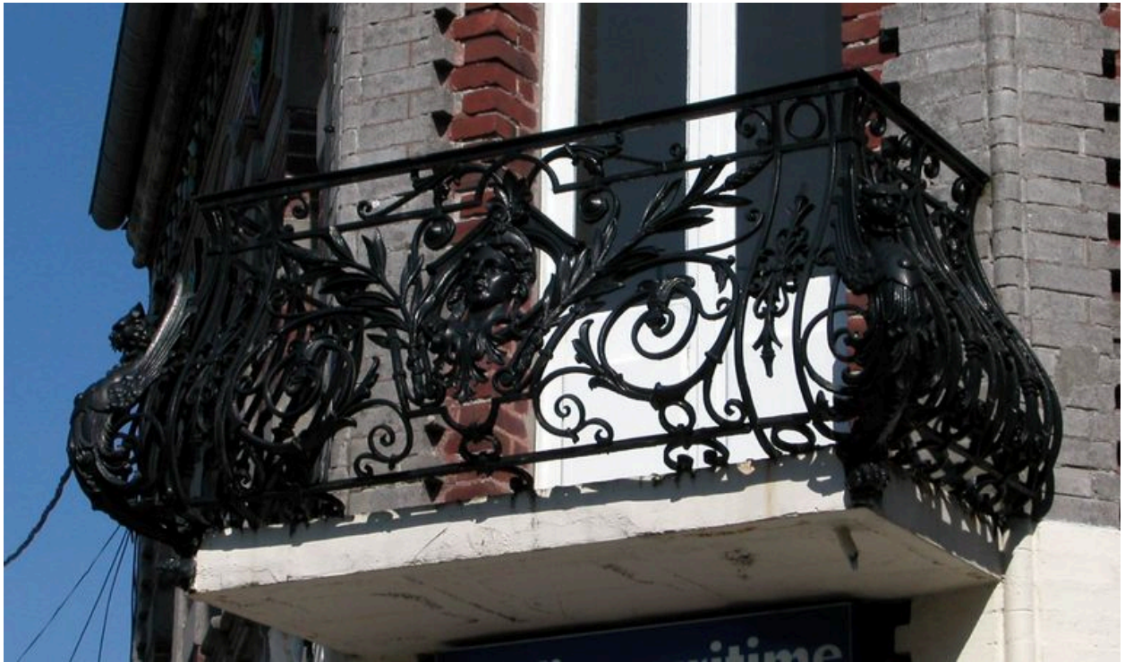
Détail du balcon en fonderie.
