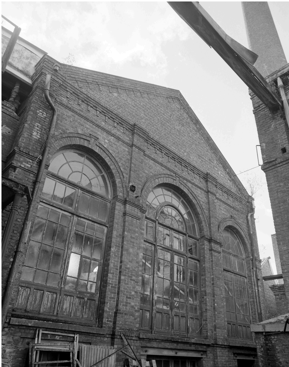
Seconde salle des machines. Élévation postérieure.
