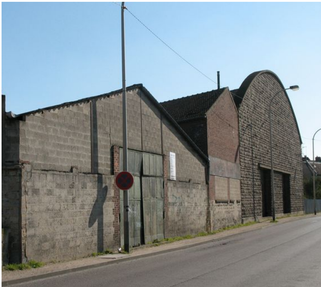
Façades des entrepôts depuis la gare.
