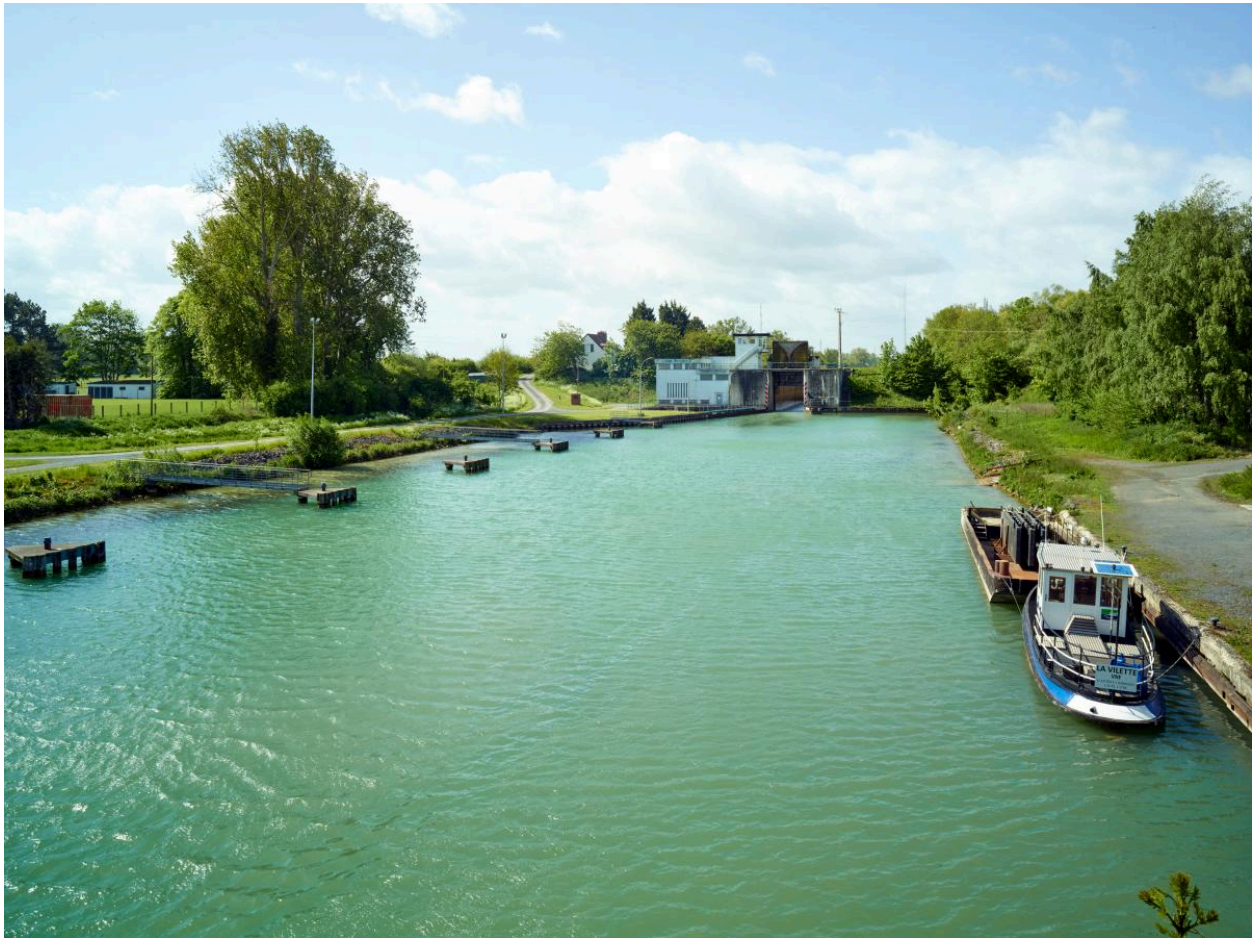
Vue générale en aval du site, prise depuis le pont routier.
