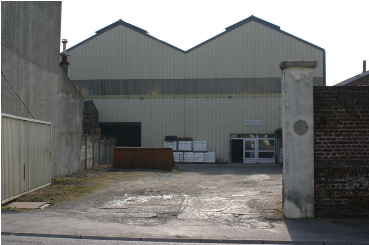
Cour et façade antérieure des entrepôts.
