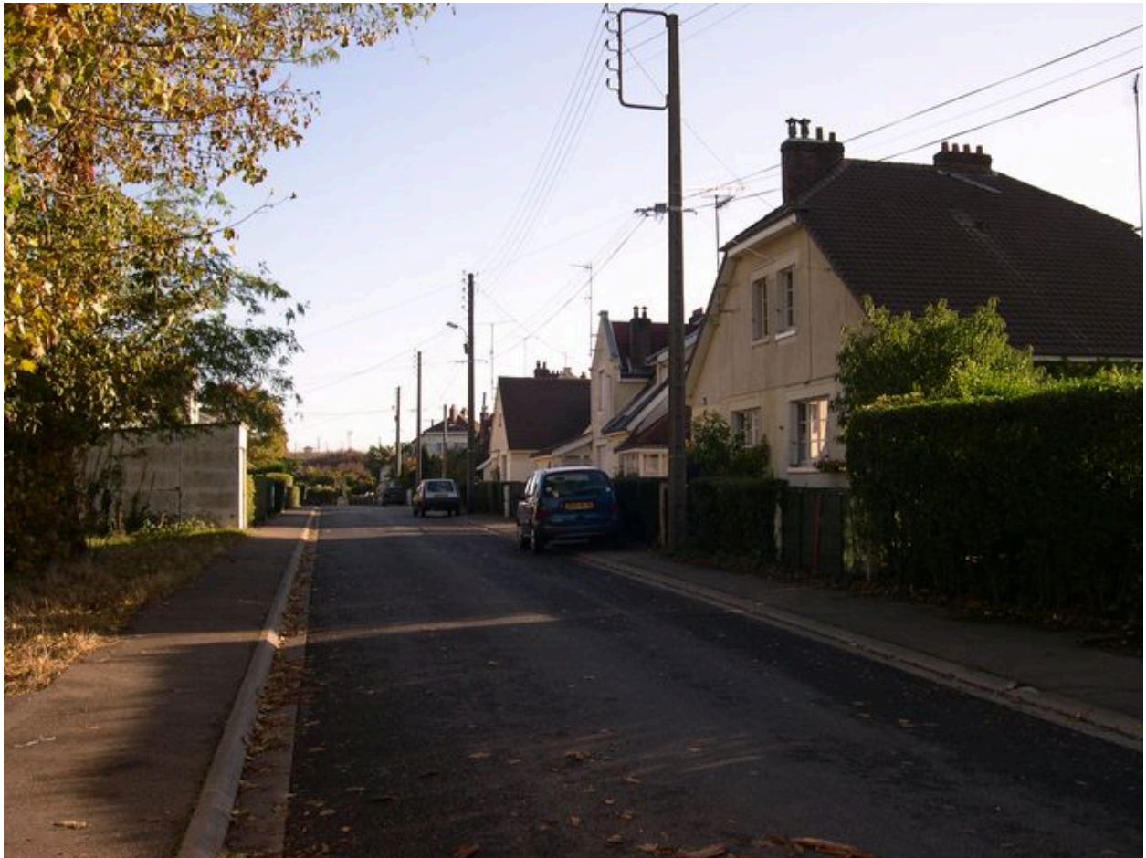
L'allée des Rosiers, vue prise en 2004 depuis l'ouest avant restauration.
