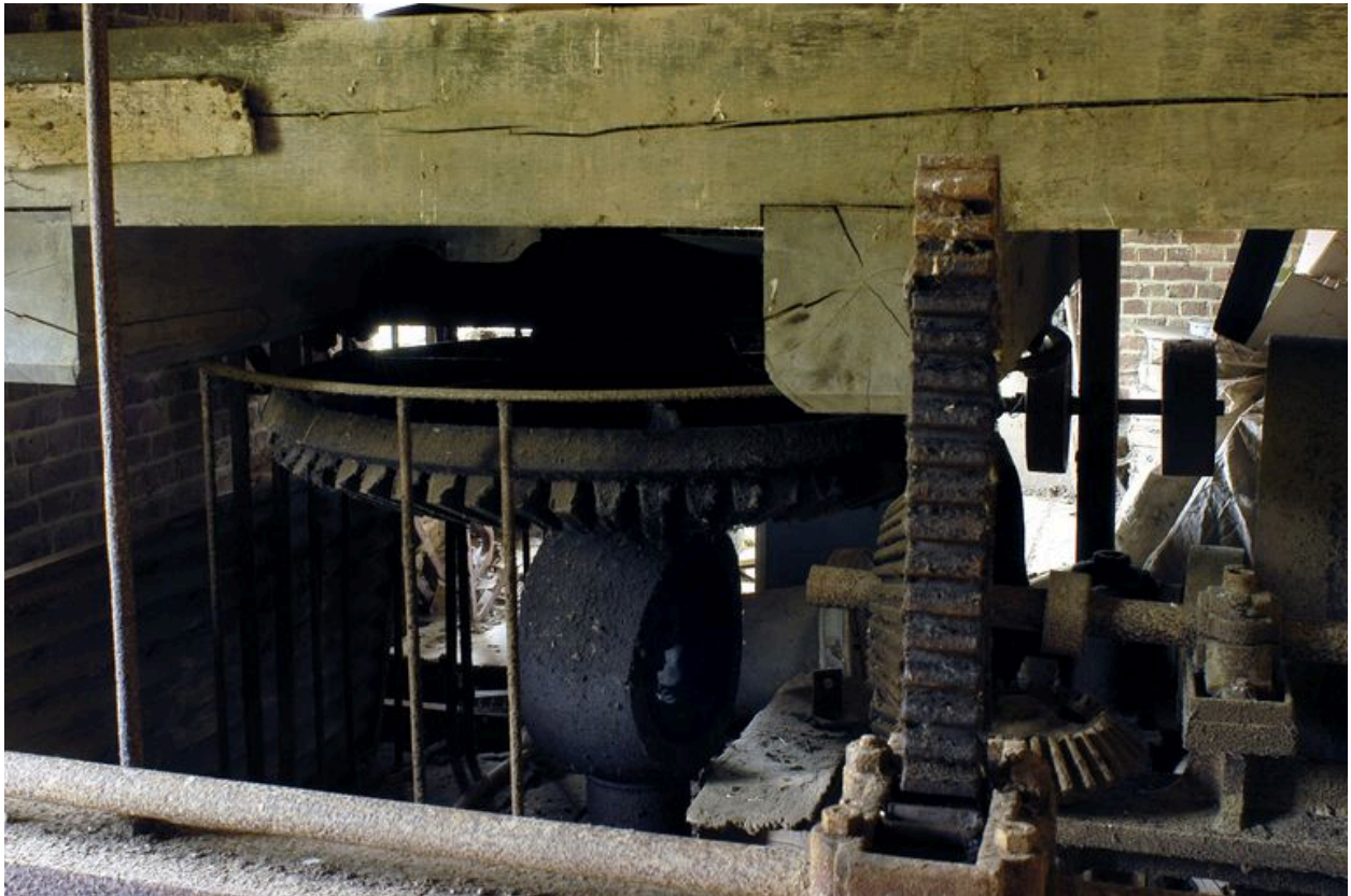
Engrenages de transmission situés au-dessus de la turbine.
