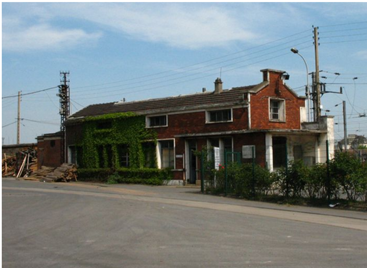
Le bâtiment de la pointeuse à l'entrée de l'usine.
