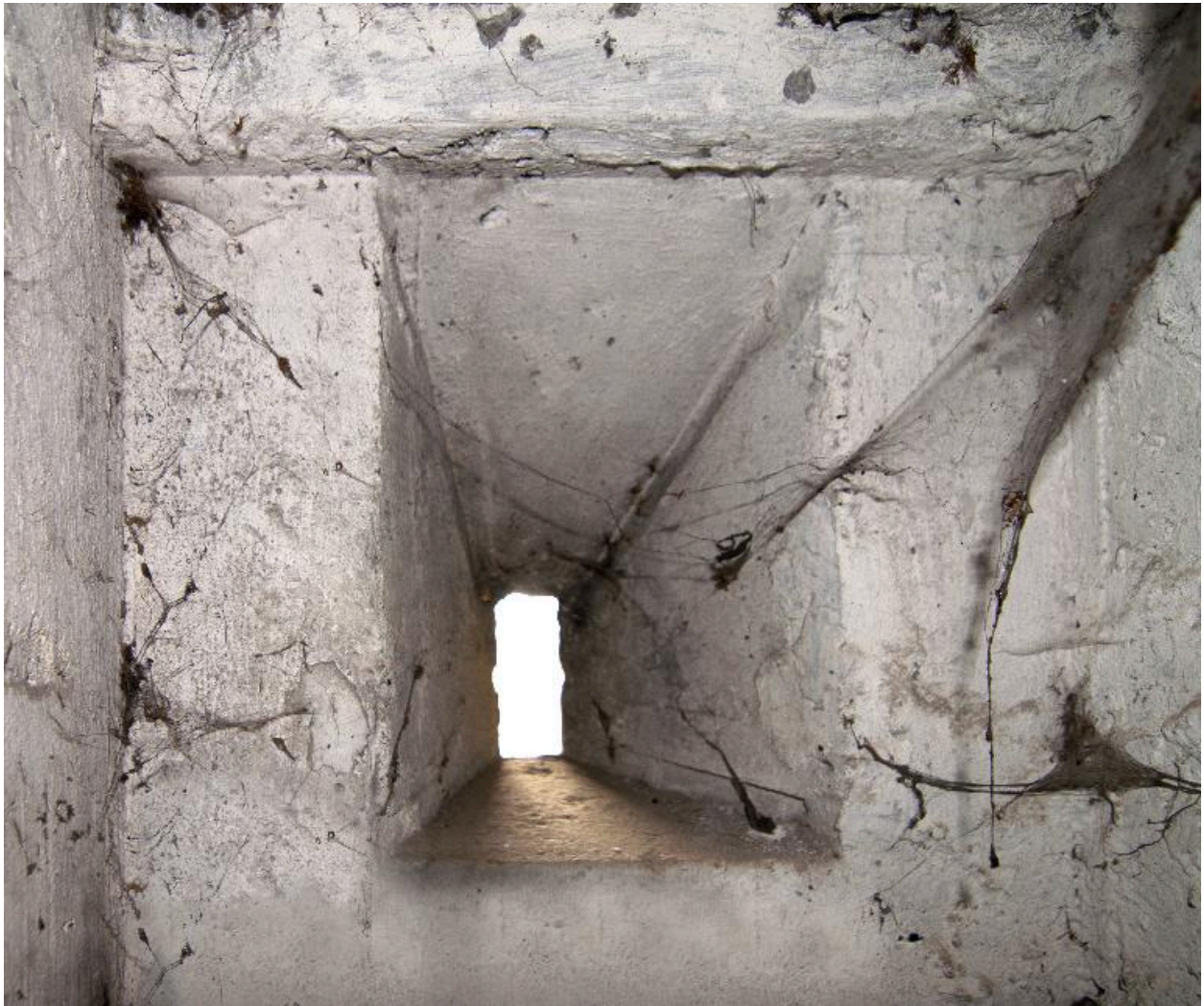
Coursière de tir, détail d'un créneau de fusillade
