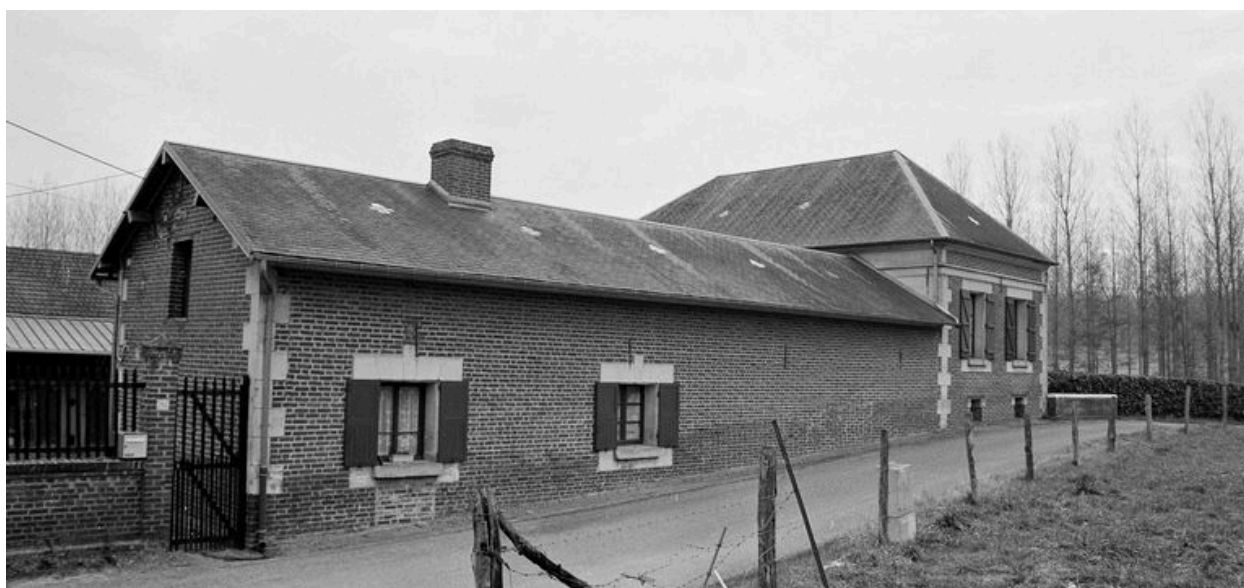
Maison d'habitation du moulin : façade sur rue.
