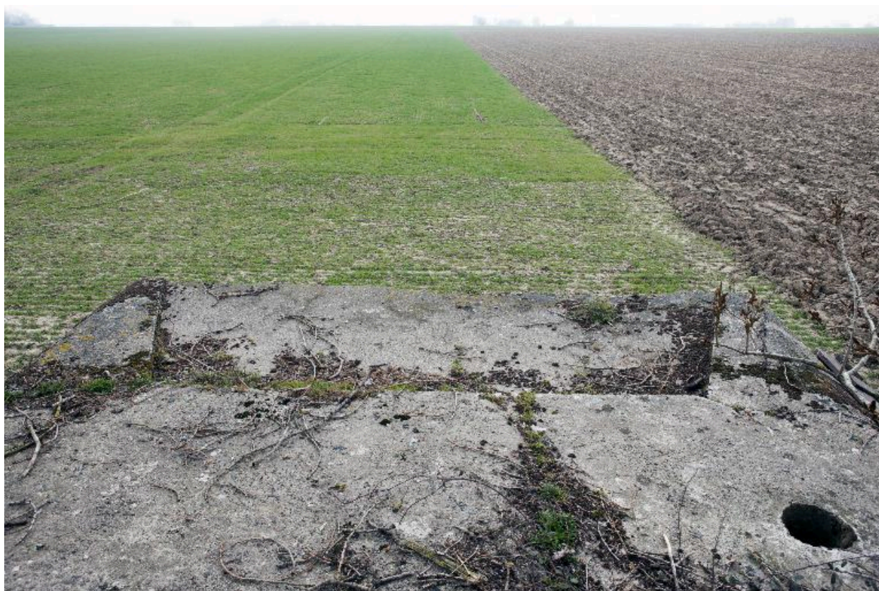
Le couvrement avec la cuve à mitrailleuse, vers le sud-est
