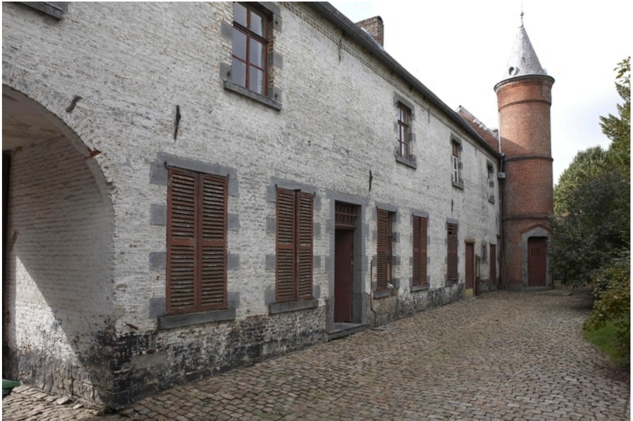
Vue de l'élévation sur cour du logis.
