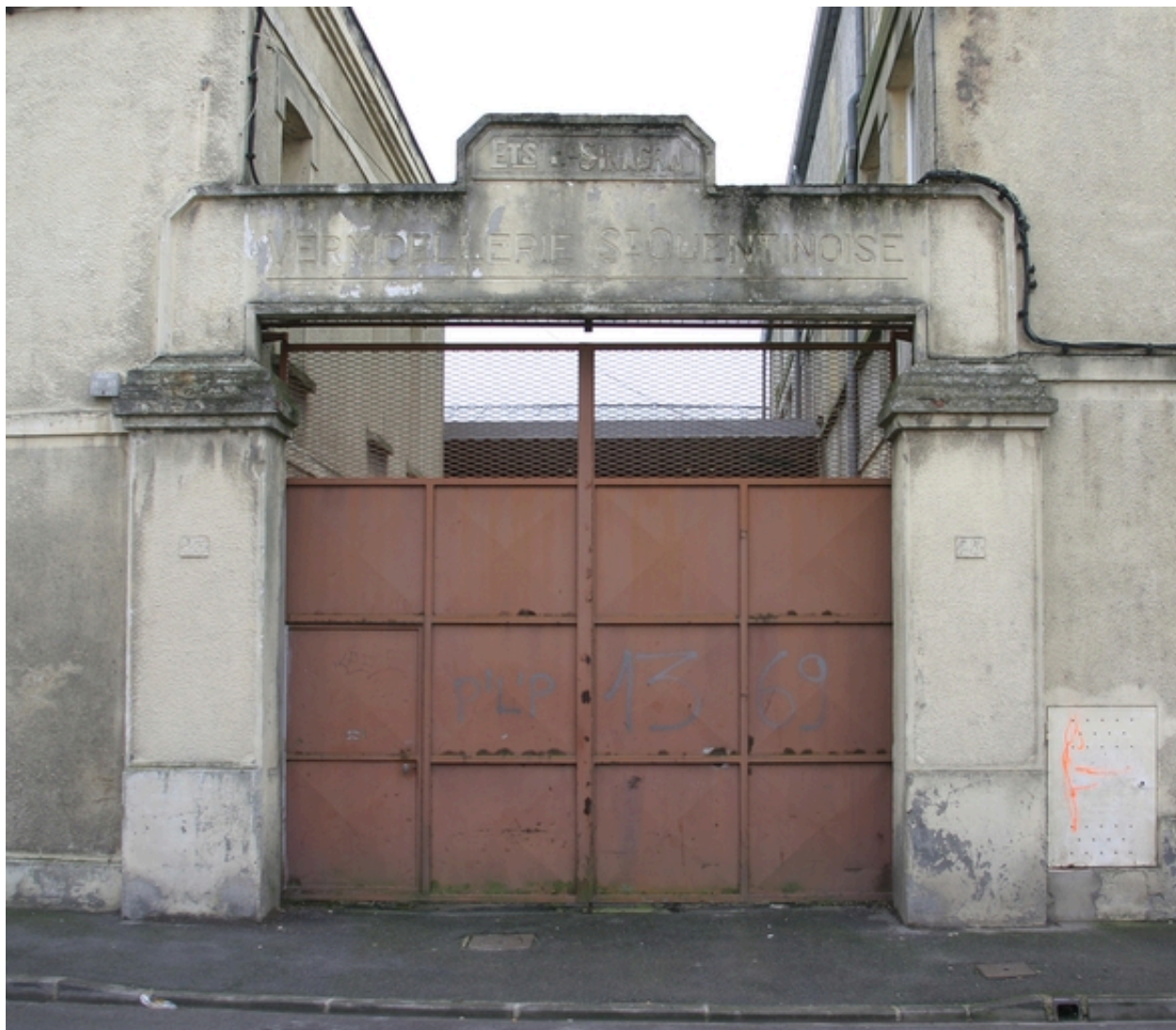
Portail d'entrée de la vermicellerie.
