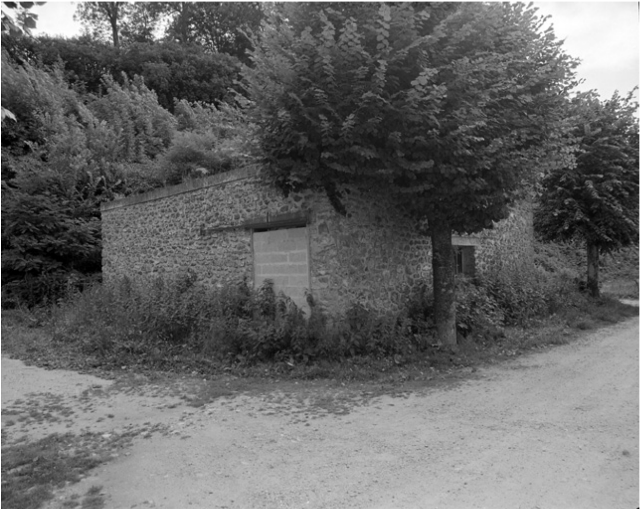
Cour Renan. Lavoir, fontaine : vue extérieure du lavoir.
