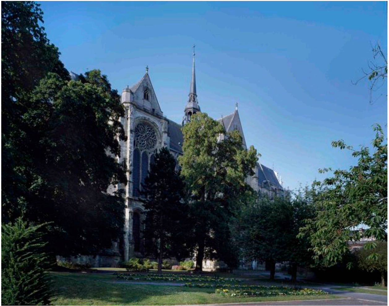
Vue de l'élévation nord.
