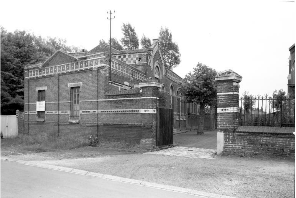
Salle paroissiale. Pignon et entrée de la cour.
