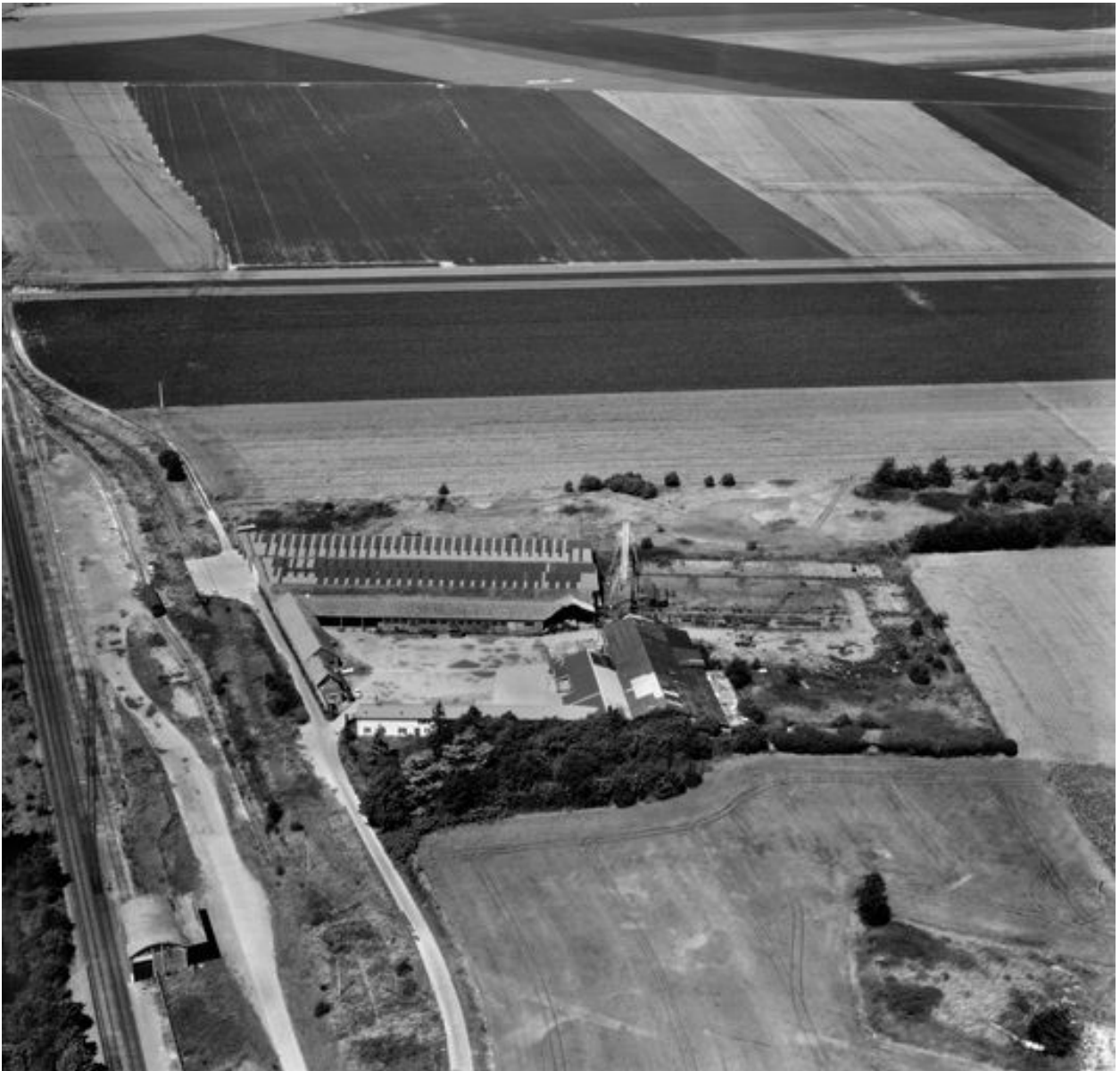
Vue aérienne, flanc est.
