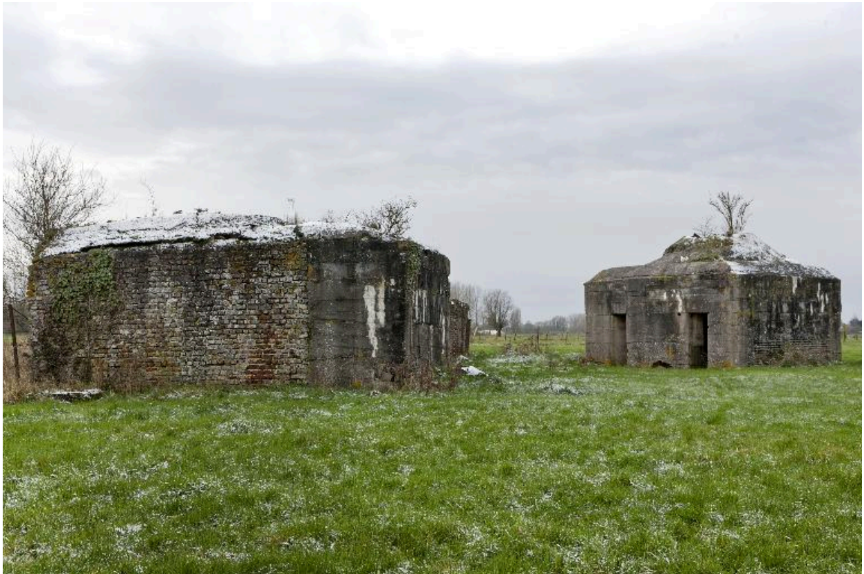
Les deux casmates, vues vers le sud-ouest.
