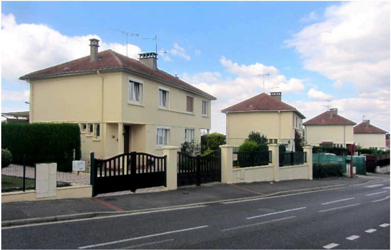
Maisons de la cité Maguin construites en 1958. Vue générale de la rue Paul-Doumer.
