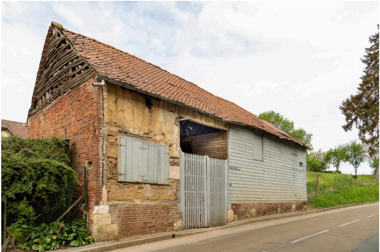
Ancien atelier de tabletier ?, n°43 Rue Principale, vue depuis l'est.
