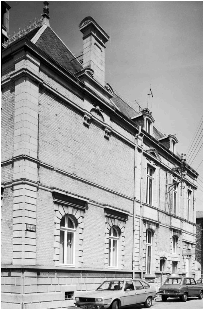
Elévation latérale, rue du Prince-Impérial, en 1981.
