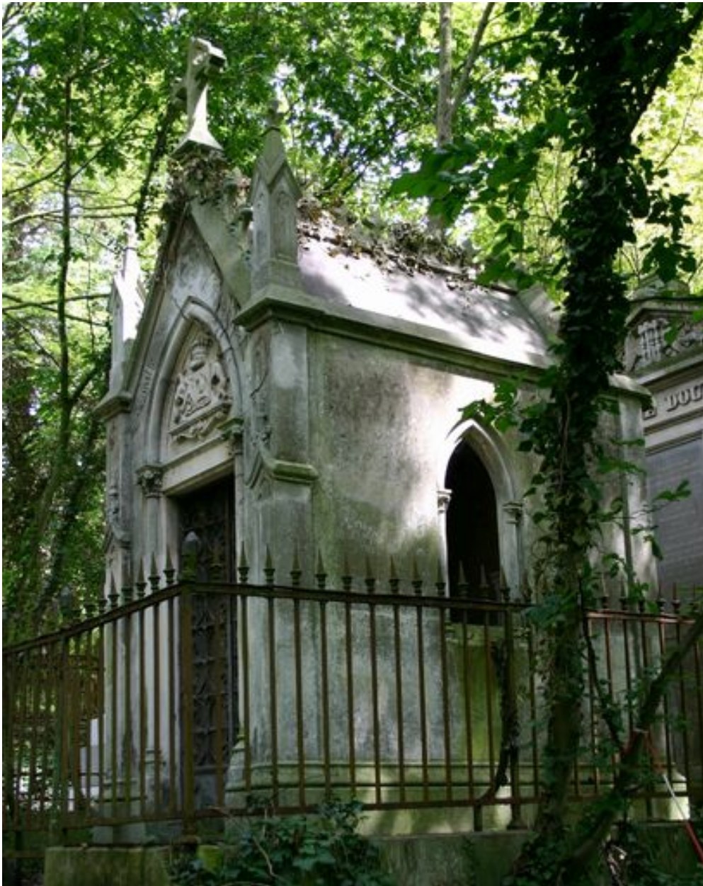
Tombeau en forme de chapelle, depuis le côté droit.
