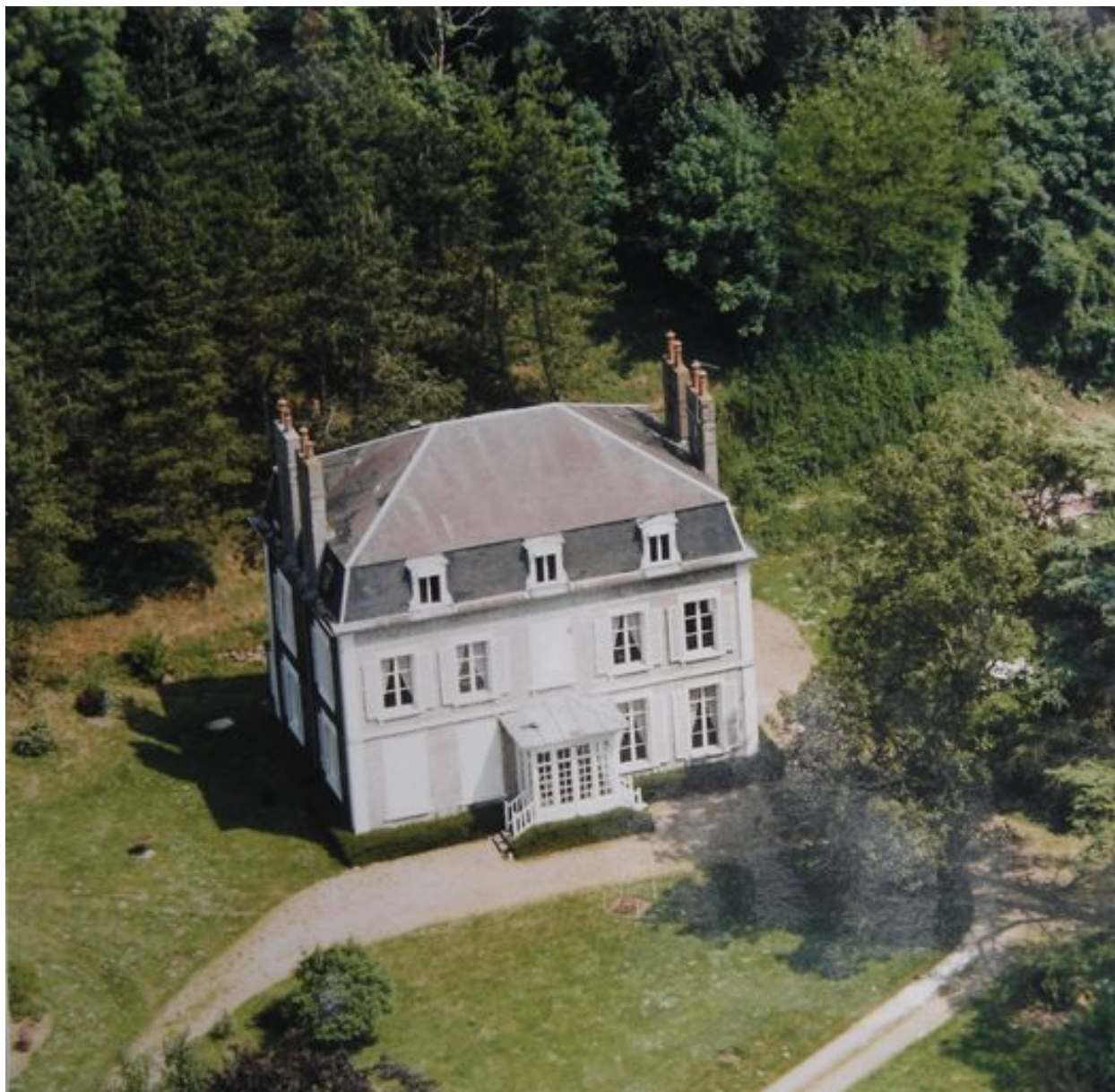
Vue aérienne du château avant l'incendie.
