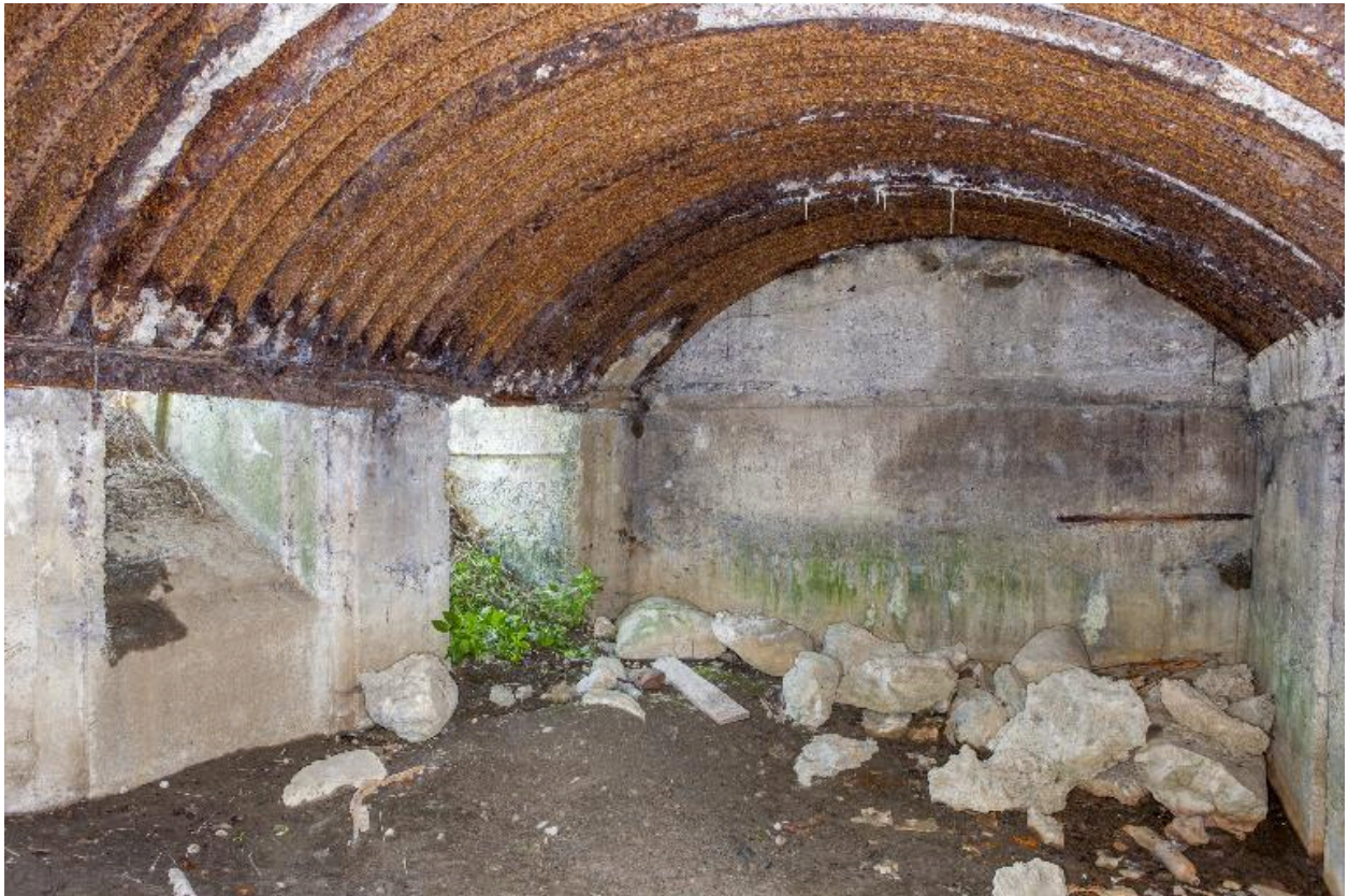
Vue intérieure vers le sud-ouest
