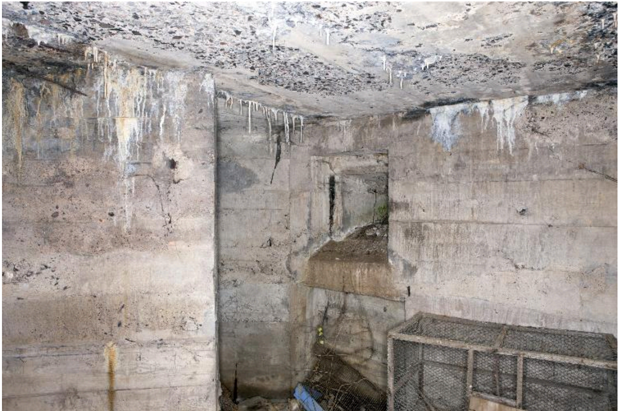
Couloir de sortie de la salle sud : A droite, un créneau de fusillade
